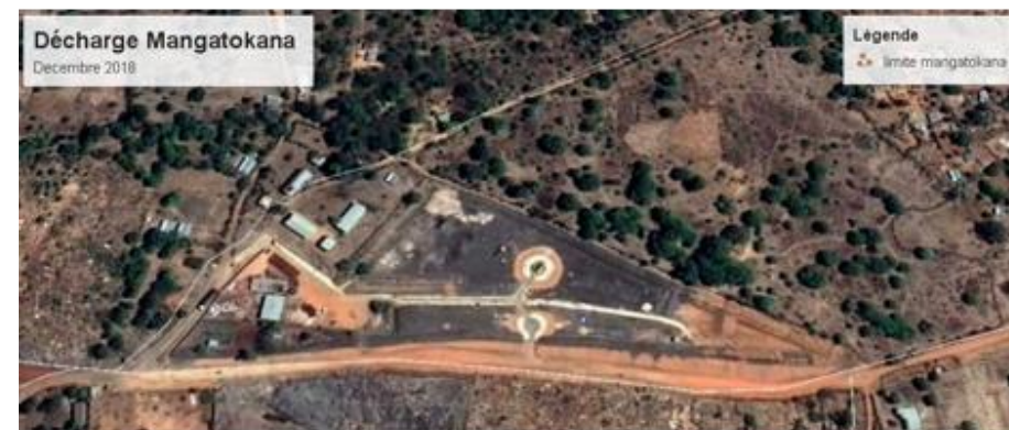
Décharge Mangatokana après les travaux, Décembre 2018 -@Google 2018
